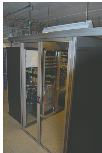
Koldgangskuben adskiller den kolde og varm luft
