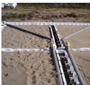
Konstruktionsopbygning med Izodom byggeblokke.
