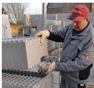
Konstruktionsopbygning med Izodom byggeblokke.
