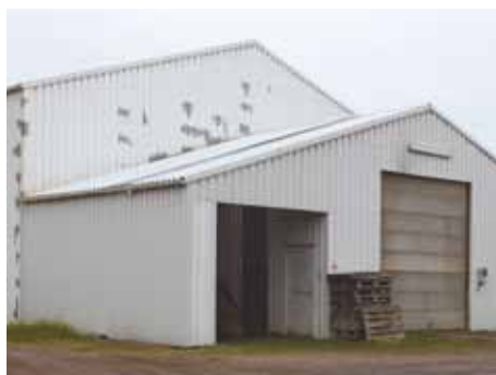
Gylle og industriaffald modtages i lagerhallen.
