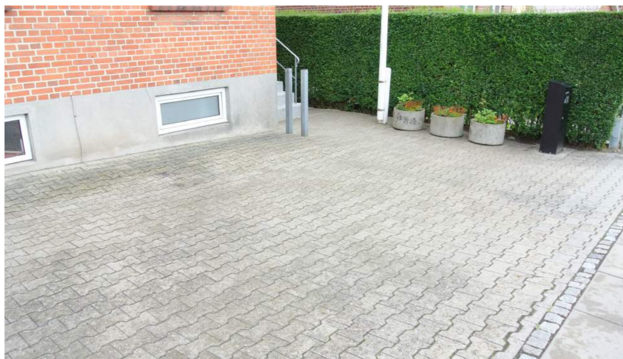
Mange private grunde har en høj belægningsgrad, der skaber meget spildevand. (Foto: Lene Alsbjörn)
