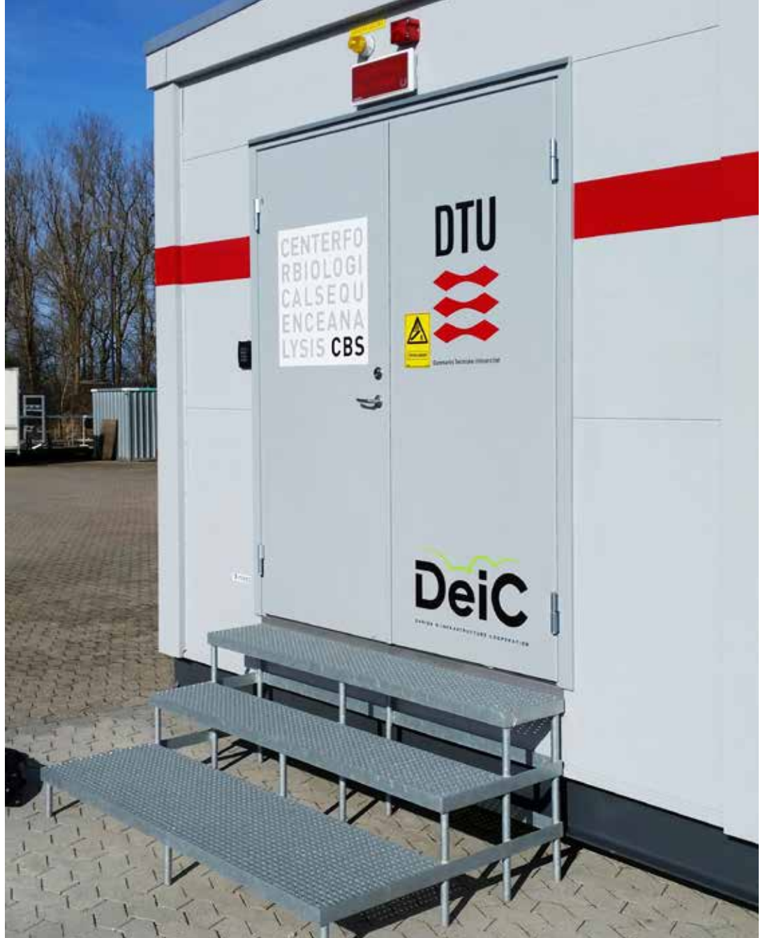
Figur 13: DeiC Nationale LifeScience Supercomputer er opbygget i to containere ved DTU, Rissø
